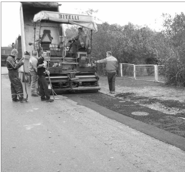
Ielas seguma atjaunošana Zvejnieku ielā.
